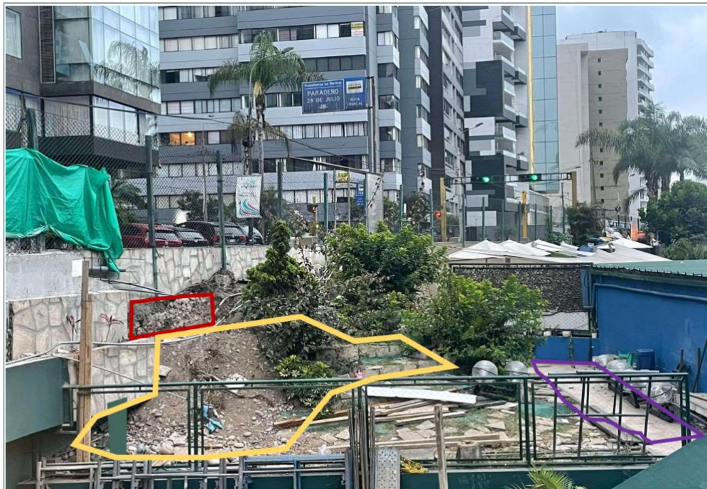
MURO DE CONTENCIÓN – FACHADA CLUB TERRAZAS
